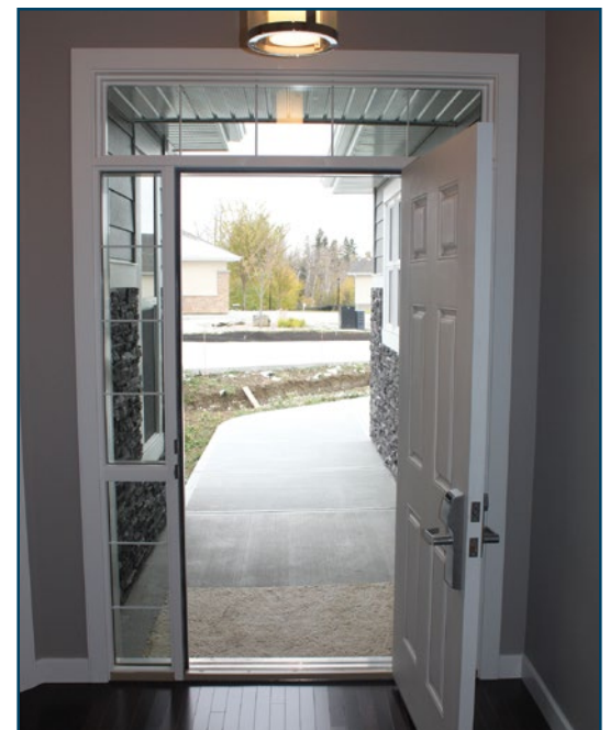
Figure 6 : Fenêtre pleine hauteur à côté de la porte d'entrée Photo : Ron Wickman
