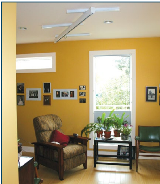
Figure 8 : Lève-personne de plafond au-dessus d'un fauteuil dans la salle de séjour Photo : Ron Wickman
