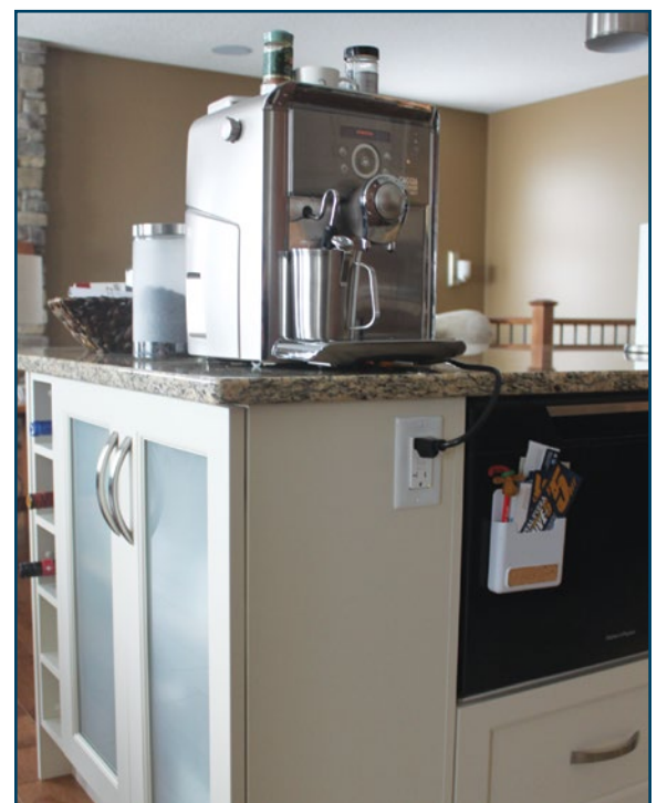
Figure 17 : Prise de courant sous le comptoir
