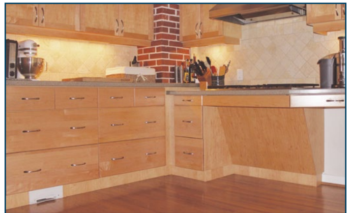
Figure 18 : Système d'aspirateur central avec prise sur la plinthe de l'armoire de cuisine Photo : Ron Wickman
