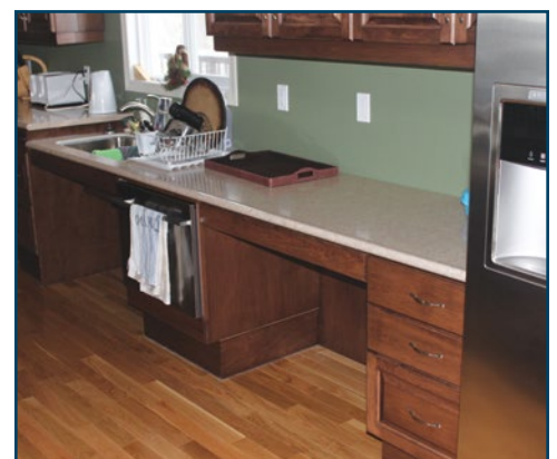
Figure 9 : Surface de travail à hauteur réduite Photo : Ron Wickman
