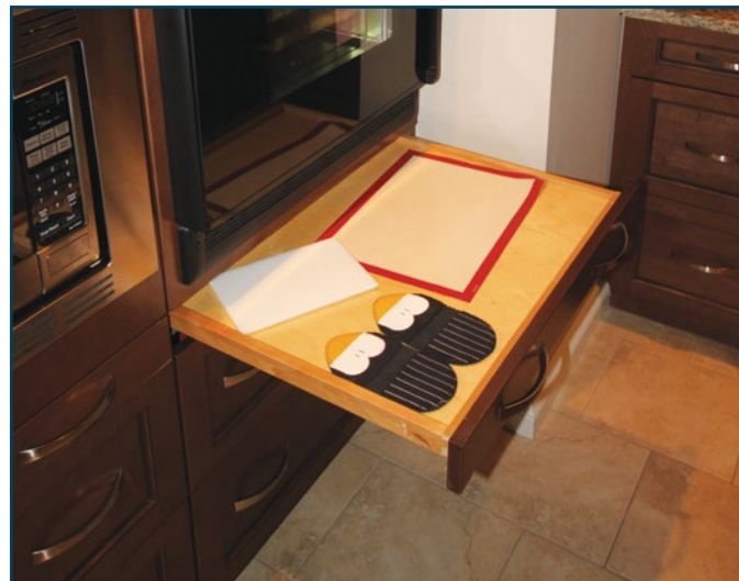
Figure 14 : Une tablette escamotable placée sous le four peut servir à placer des ustensiles ou des aliments à mettre au four
