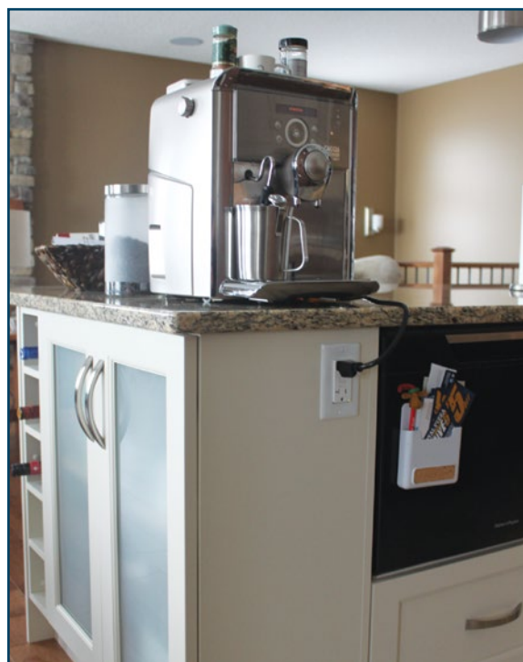
Figure 17 : Prise de courant sous le comptoir
