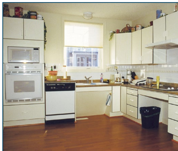
Figure 15 : Cuisine accessible avec espace libre sous l'évier et protection des tuyaux afin de prévenir les brûlures aux jambes
