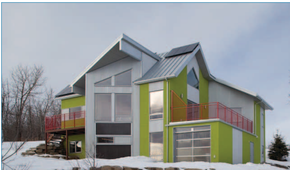
Figure 1 – Façade sud de la maison EQuilibrium MC EchoHaven
